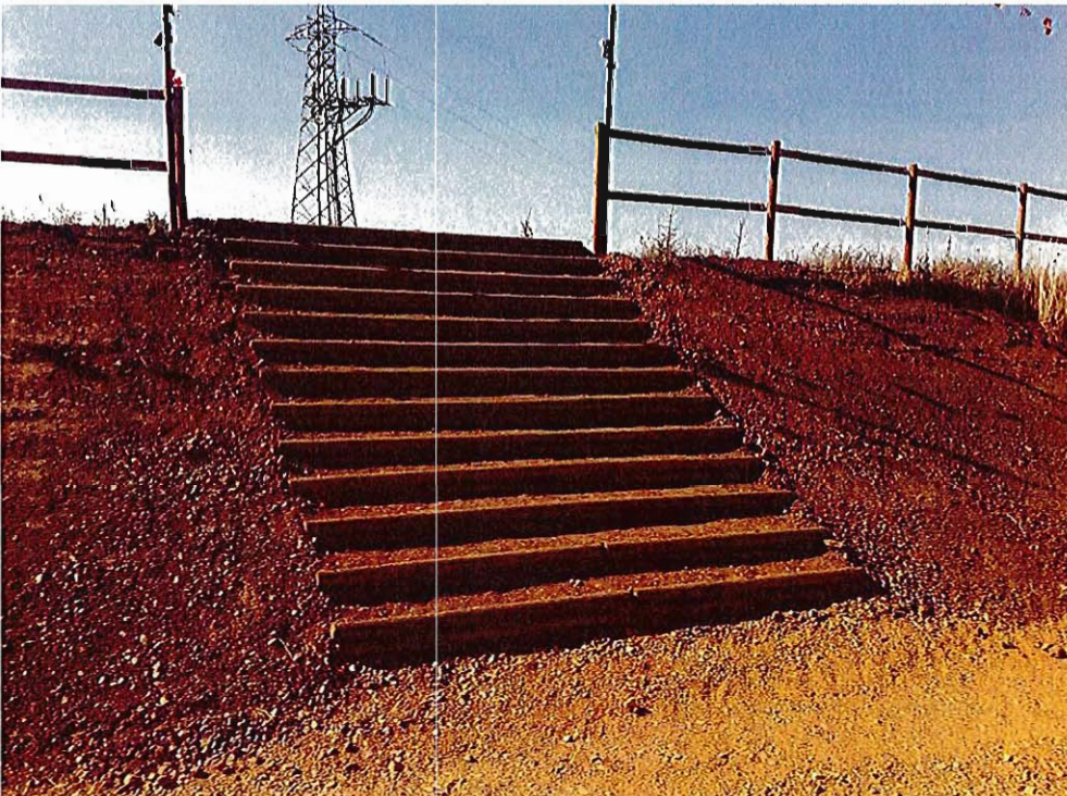
Escaleras de acceso desde la parcela a la zona del embalse del azud
