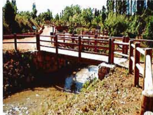
Pasarela peatonal sobre el río Salobre, de tipología similar a la propuesta.
