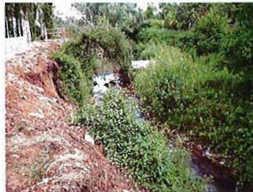
Zona de emplazamiento de la nueva represa.
