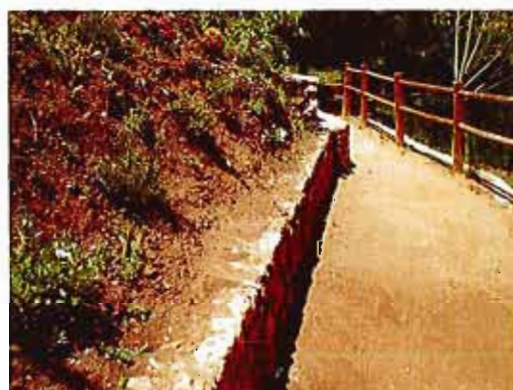
Estado de los muretes objeto de las obras de recrecido.
