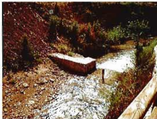
Represa existente en el río Salobre a su paso por la localidad.
