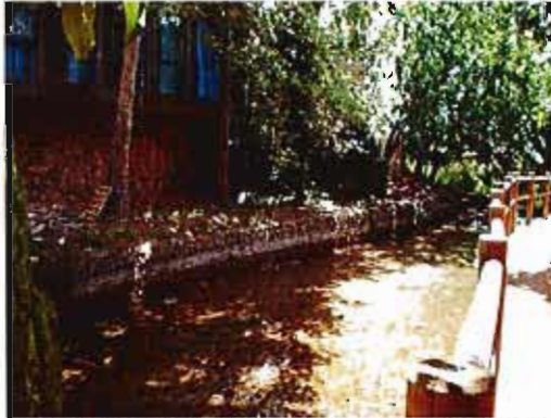
Mirador (parte superior izda.) y emplazamiento de pasarela y escalera de acceso
