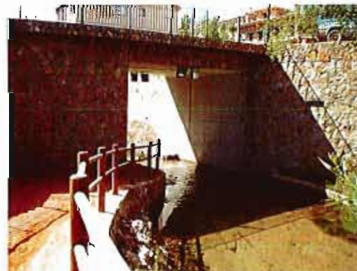
Puente objeto del revestimiento interior.
