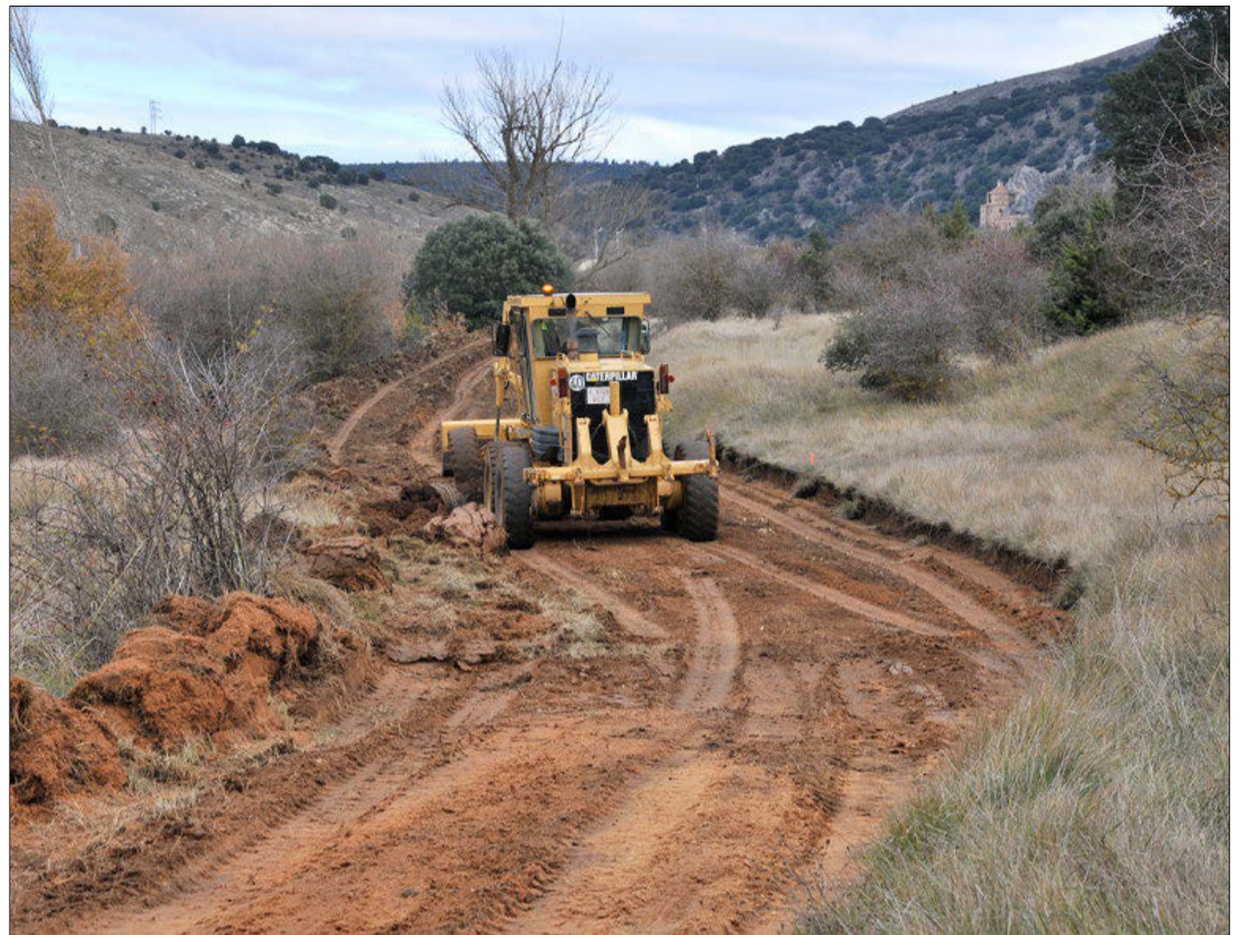
Obras previas realizadas en el pasado mes de noviembre. VALENTÍN GUISANDE
