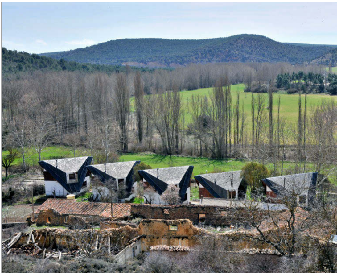
Terrenos donde se ubicará la nueva depuradora de Soria en Sinova. VALENTÍN GUISANDE
