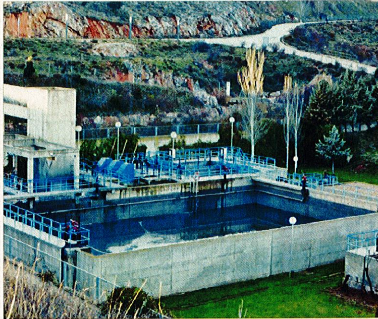
Vista general de la actual estación depuradora de Soria. MARIO TEJEDOR
