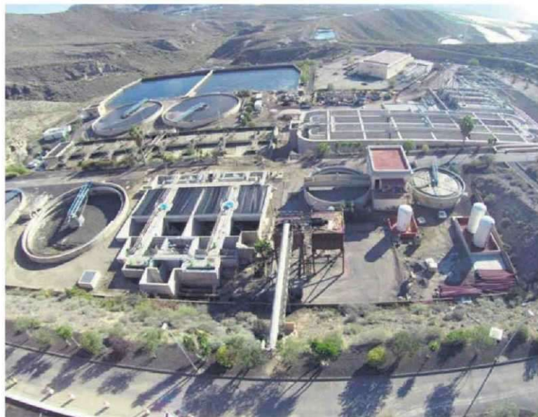
ESTACIÓN DEPURADORA DE ADEJE-ARONA. DA
