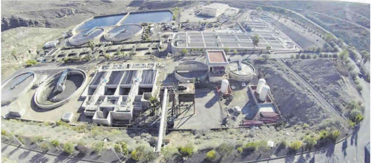
Conjunto de la instalación. | E.D.
