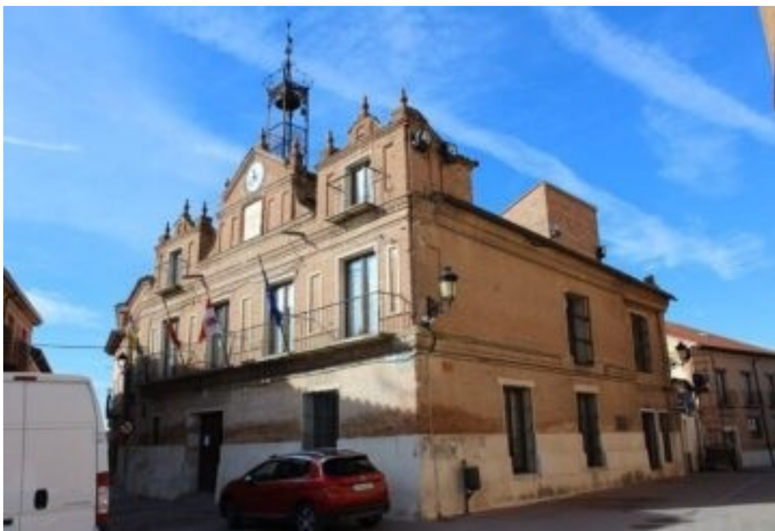
Autorizada una nueva depuradora en Fresno el Viejo
