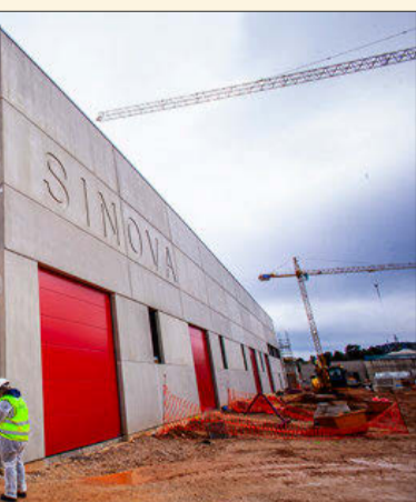
las puertas de las instalaciones en rojo, circunstancia que solo se da en otra depuradora de España, en Orense.
