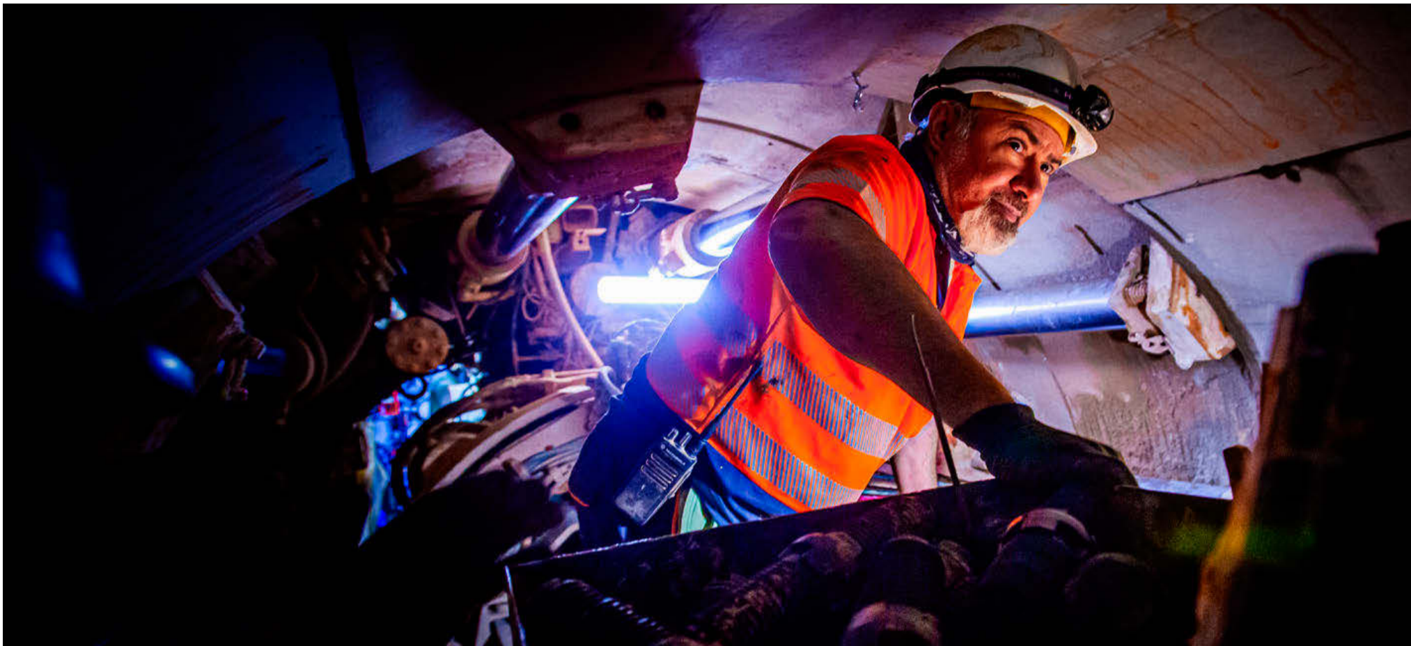
Uno de los operarios que trabaja en la excavación del túnel en la zona de cabecera de la tuneladora Saturaia. REPORTAJE GRÁFICO: MARIO TEJEDOR
