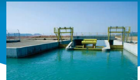
Obra de entrada de agua
