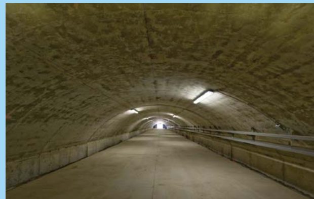
Galería de acceso a los desagües de fondo
